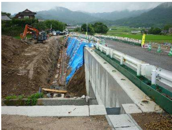
施工現場：土木(田染道路)
