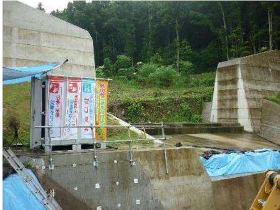
施工現場：土木(都甲砂防ダム)
